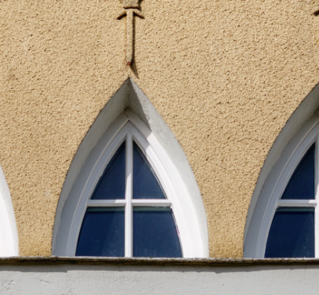
Dachfenster, Siedlung Heeper Fichten, Bielefeld | Luise Wagener 2023
