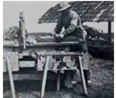
Ziegelerbeiter beim Streichen der Ziegel in einer Doppelform, Bild LWL-Industriemuseum
